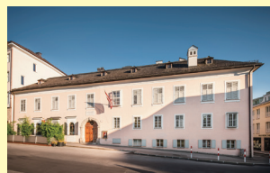
▲1996年復元修復完成
